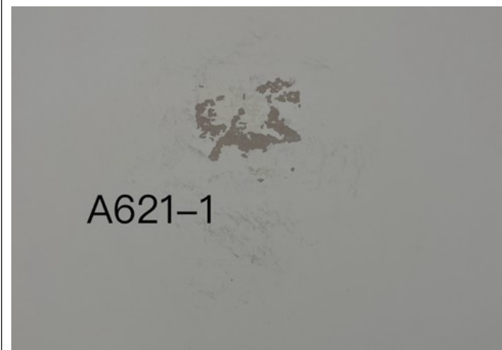
6 樓 A621-1 牆壁油漆剝落
